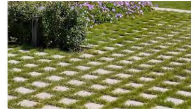
Pavage à joints filtrants réalisés au sable et/ou enherbés
