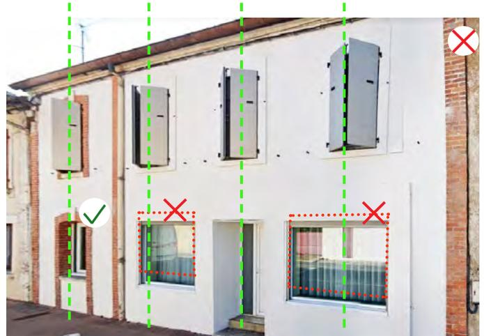
> Transformation des ouvertures du RDC : Élargissement des ouvertures existantes, suppression des encadrements en briques
