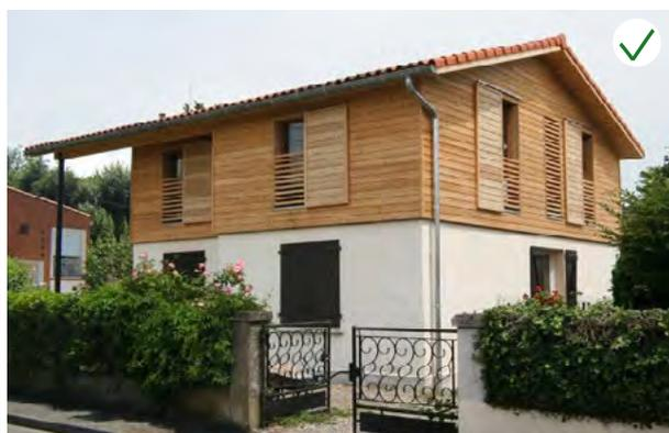
Surélévation en structure et bardage bois
