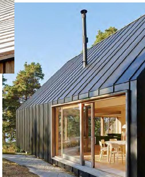
> Toitures simples à 2 pans sans débord de toit avec le même matériaux en façade et en toiture
