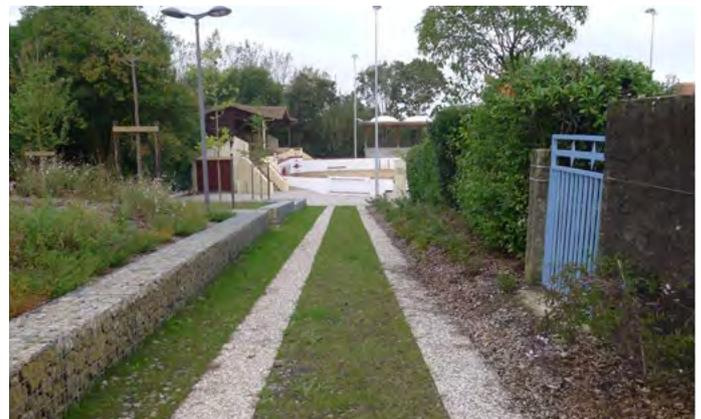
Image de référence : aménagement d'un chemin de roue en béton en lieu et place d'une voie d'accès toute largeur en béton (Donzac).
