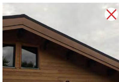
> On évitera l'utilisation des bandeaux sur les murs gouttereaux (Façades) pour laisser les chevrons apparents.
