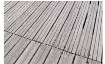
Platelage de lames de bois pour terrasses, permettant une infiltration des eaux entre les joints
