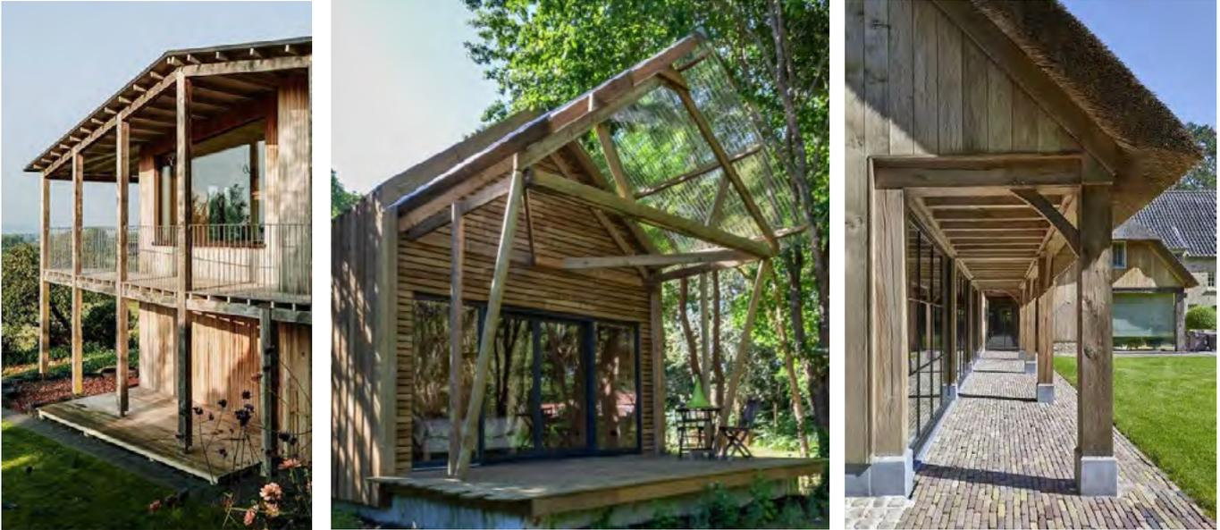
Différents types d'assemblage de charpente sont possibles pour soutenir les larges débords de toit sans poteau . Une ré-interprétation du corbeau traditionnel (type d'assemblage, matérialité, ...) confère au bâtiment une écriture plus contemporaine. On évitera ainsi le jambage apparent, pour plus de légèreté.
