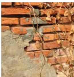
Défaut d'étanchéité lié à l'usure de l'enduit
