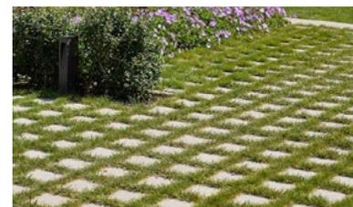
Pavage à joints filtrants réalisés au sable et/ou enherbés
