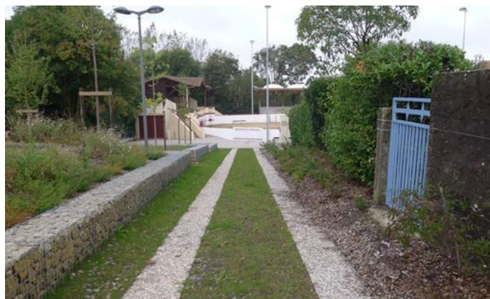
Image de référence : aménagement d'un chemin de roue en béton en lieu et place d'une voie d'accès toute large en béton (Donzac).
