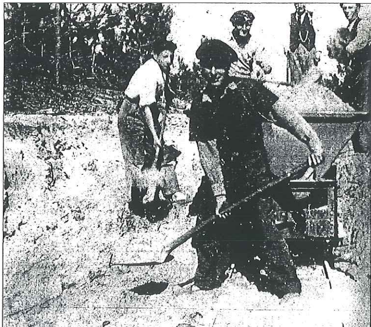
Photo 24 : La construction de la route du Penon. Avec l'aimable autorisation de M. Jean Suscosse.
